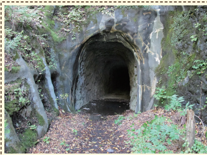
ずい道 (トンネル)
